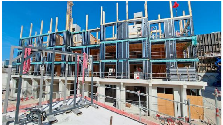
Travaux Bâtiment PB9 ©Thomas Charmasson – Gipen
